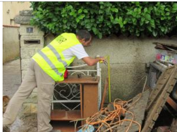
Photo prise à l'extérieur, sur le mur de clôture
