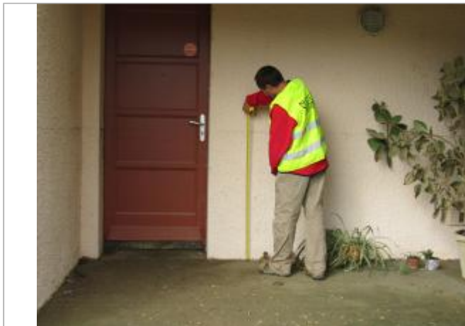
Photo prise à l'extérieur, sur la propriété privée
