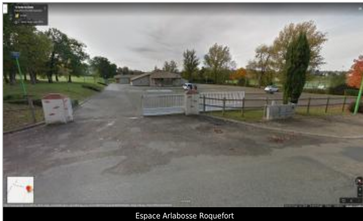
Espace Arlabosse Roquefort
