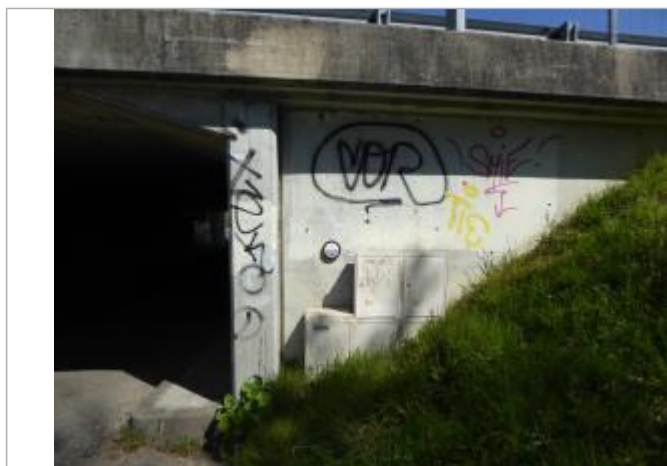
Repère de crue sur la culée du pont de l'A62 sur la rue des Fleurs à Roquefort
