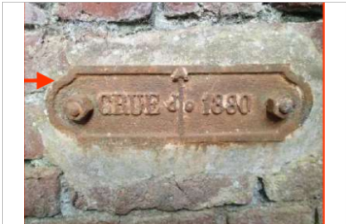
Repère derrière l'échelle limnimétrique
