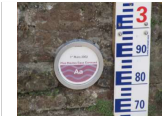
Repère en amont du pont sur le mur
