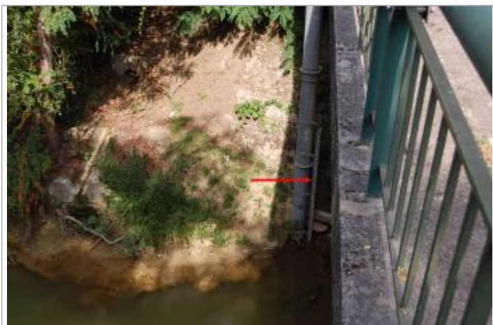
Vue de la laisse d'inondation - Auteur : GEOSPHAIR
