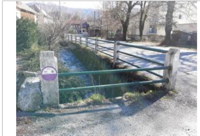
Intersection route de Savoie et RD907
