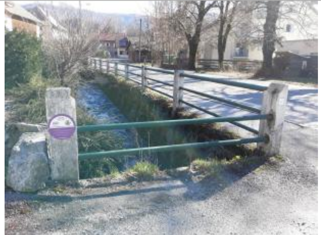
Intersection route de Savoie et RD907
