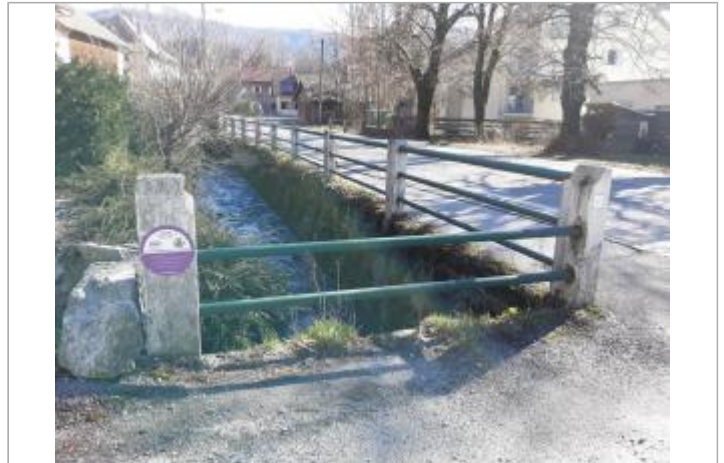
Intersection route de Savoie et RD907
