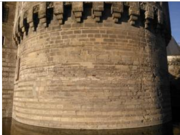
Tour sud-est du chateau des ducs de bretagne
