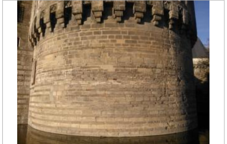
Tour sud-est du chateau des ducs de bretagne
