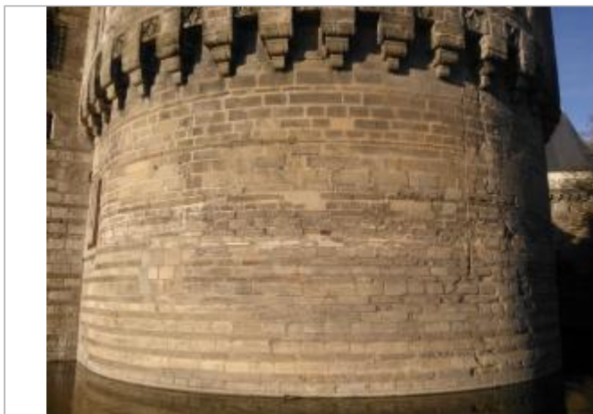
Tour sud-est du chateau des ducs de bretagne
