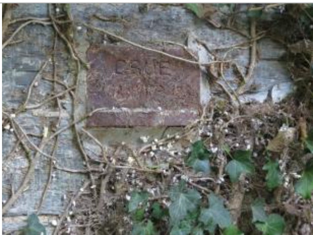
Repère de crue le 17 octobre 2018
