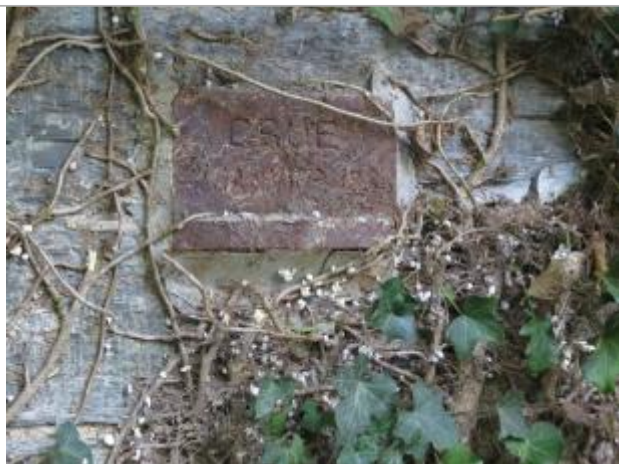
Repère de crue le 17 octobre 2018
