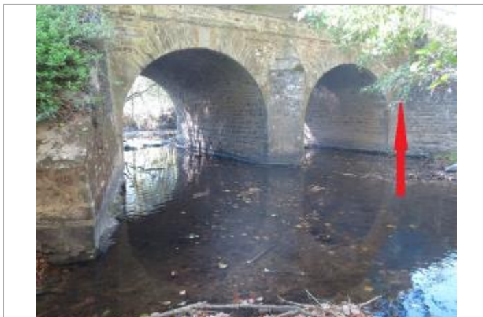
Site du pont de la RD32
