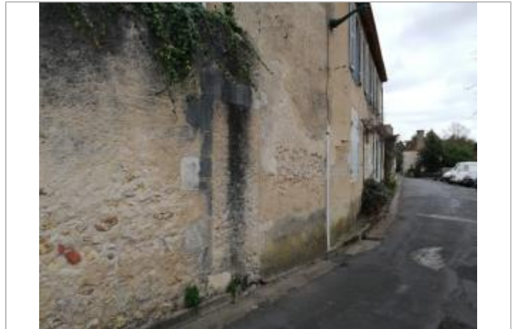
Site - rue du Puits Cornet
