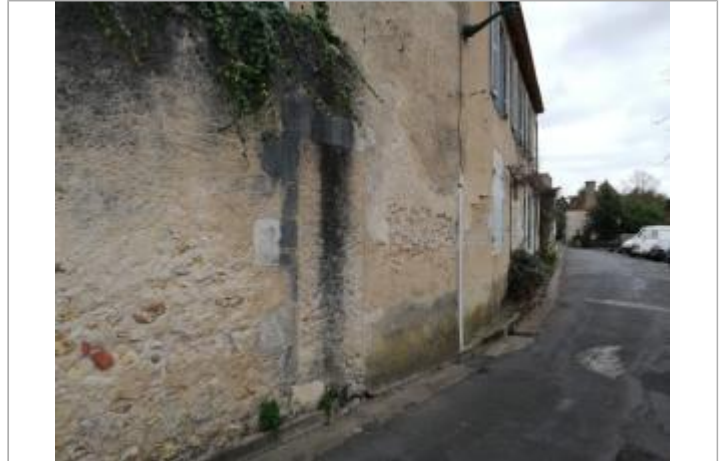
Site - rue du Puits Cornet
