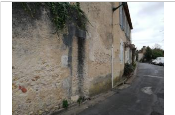
Site - rue du Puits Cornet
