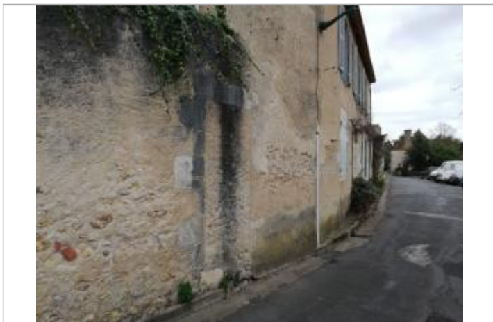
Repère vue de loin
