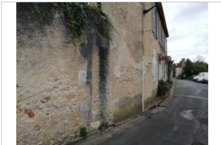
Repère vue de loin
