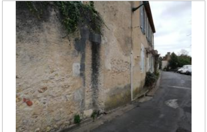
Site - rue du Puits Cornet
