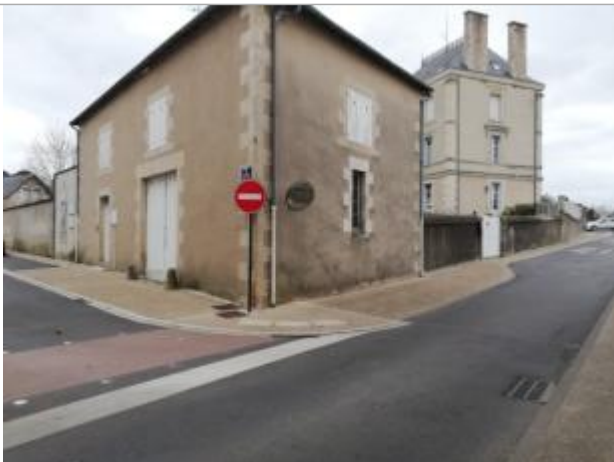
Repère vue de loin
