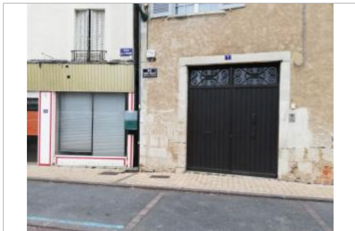
Repère vue de loin
