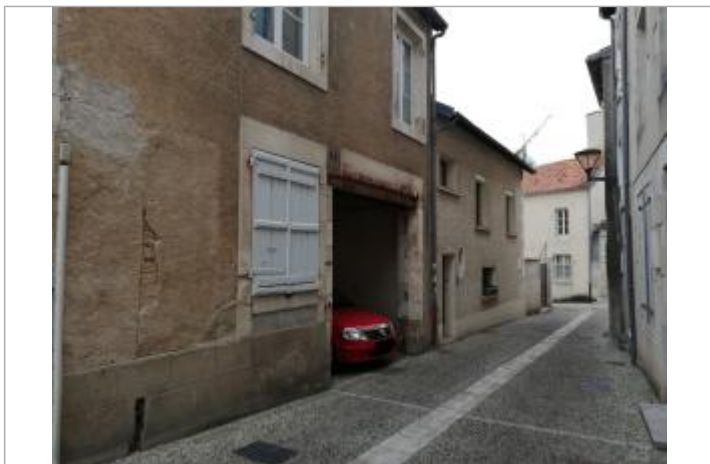
Repère vue de loin
