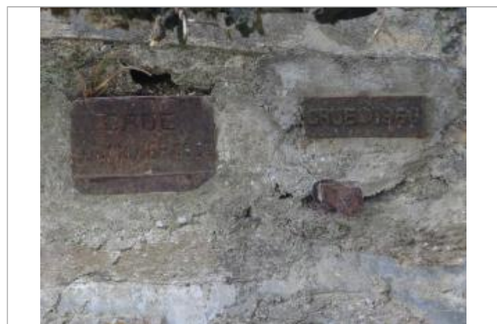
visite de contrôle le 17 octobre 2018 par le SPC VCB - photo des 2 plaques 1936 et 1966
