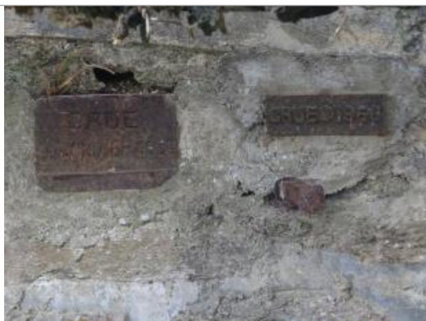
visite de contrôle le 17 octobre 2018 par le SPC VCB - photo des 2 plaques 1936 et 1966
