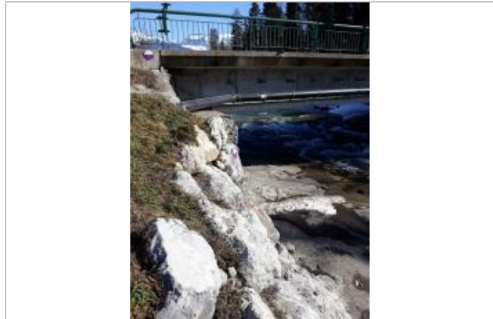
pont de la RD54
