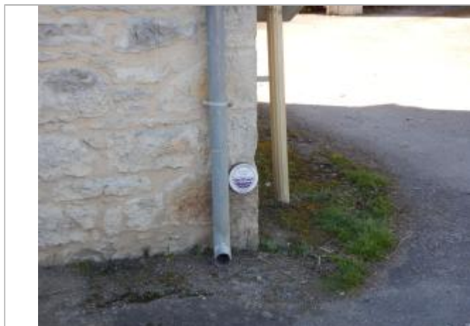
Repère de crue - décembre 1944
