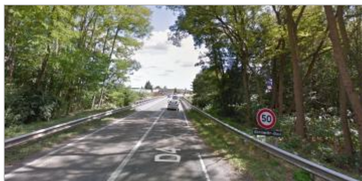
Vue générale du site
