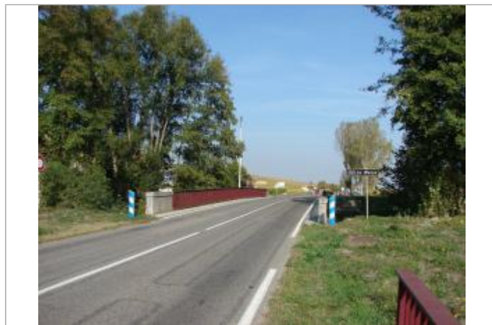
Vue général du site
