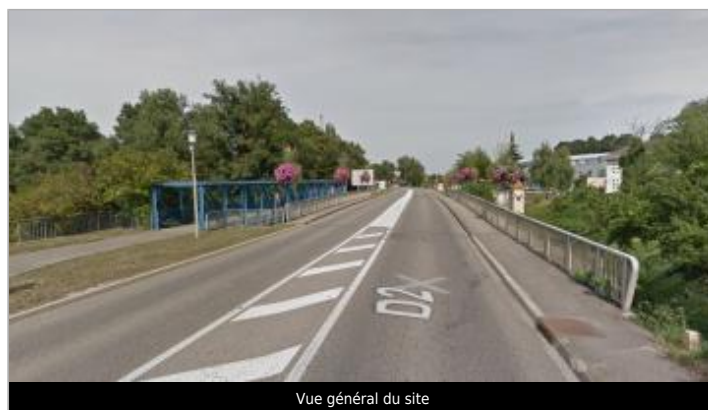
Vue général du site
