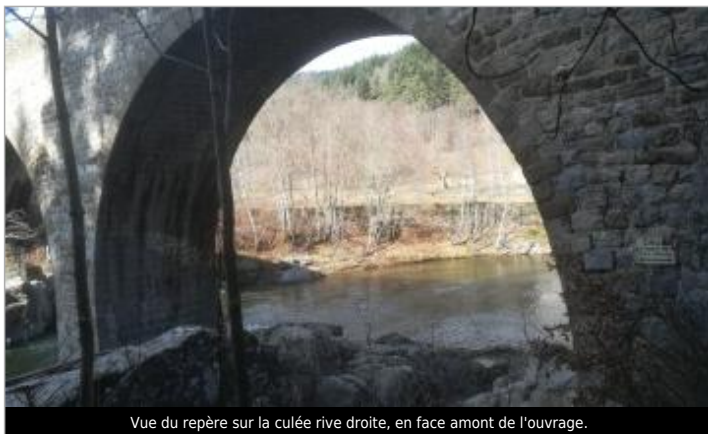
Vue du repère sur la culée rive droite, en face amont de l'ouvrage.
