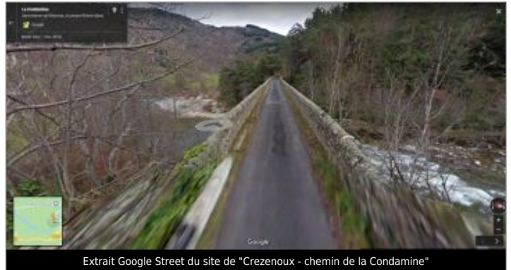
Extrait Google Street du site de "Crezenoux - chemin de la Condamine"
