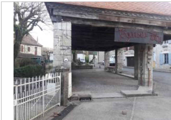
halle de Creysse
