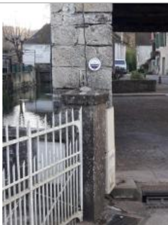
Repère de crue de 1952
