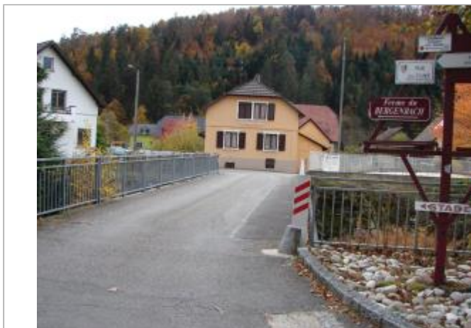
Vue générale du site
