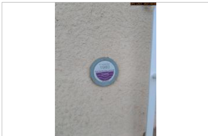
Vue du repère rapprochée en 2021
