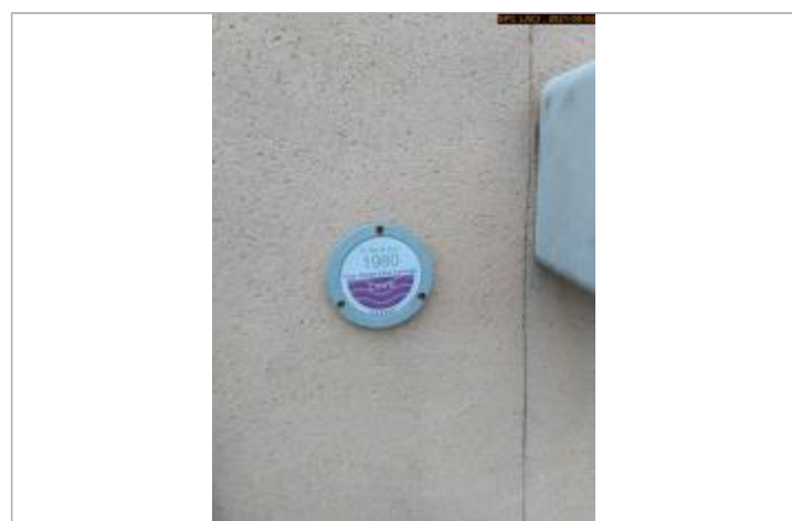
Vue du repère en 2021
