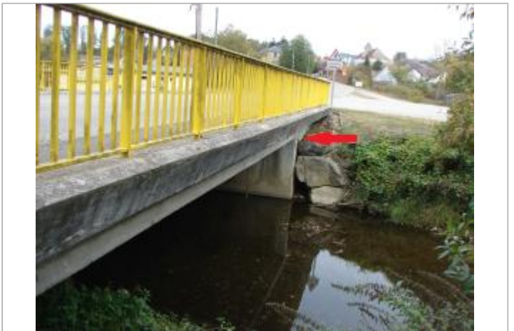
Vue général du site
