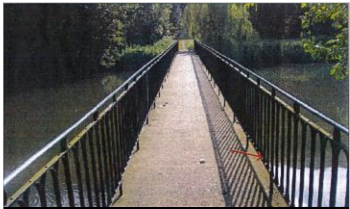
2 Rue de l'isle (photo CETE Normandie Centre)
