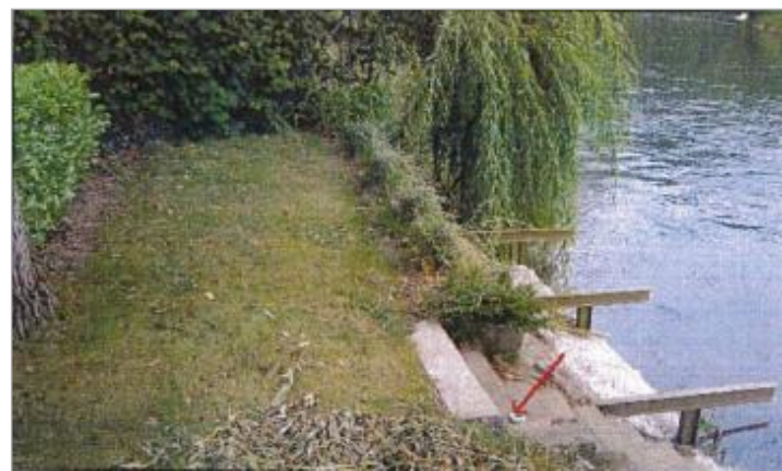
3 Rue de Louvedalle (photo CETE Normandie Centre)
