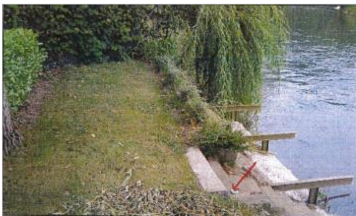
3 Rue de Louvedalle (photo CETE Normandie Centre)
