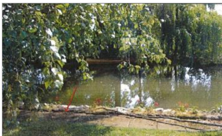
Chemin du Mouché (photo CETE Normandie Centre)
