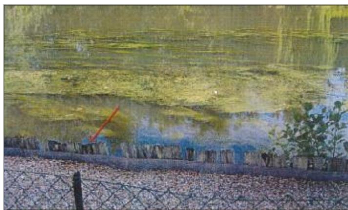
6 Sente de l'Abreuvoir (photo CETE Normandie Centre)
