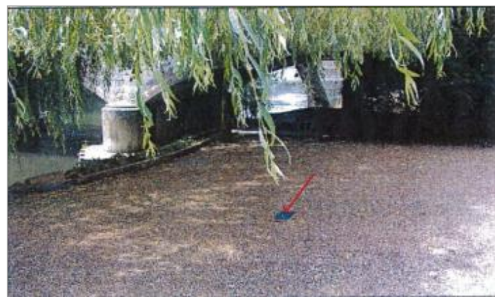
17 Route d'Evreux (photo CETE Normandie Centre)
