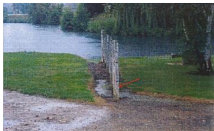
7 Rue des Marais (photo CETE Normandie Centre)
