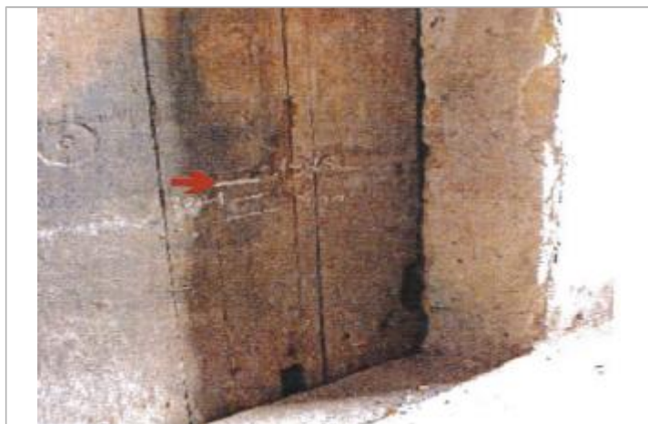
30 Rue Marie Curie (photo CETE Normandie Centre)
