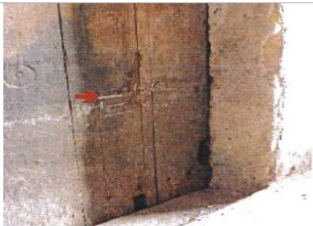
30 Rue Marie Curie (photo CETE Normandie Centre)
