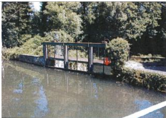
Aval usine Grands Moulins et les Cordeli (photo CETE Normandie Centre)
