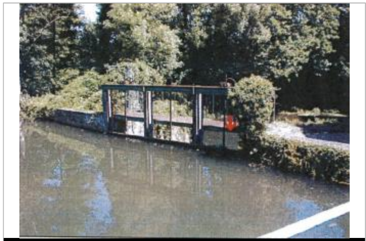
Aval usine Grands Moulins et les Cordeli (photo CETE Normandie Centre)
