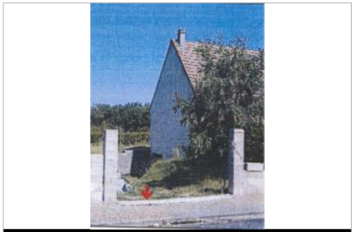
10 Le Prés Denis (photo CETE Normandie Centre)
