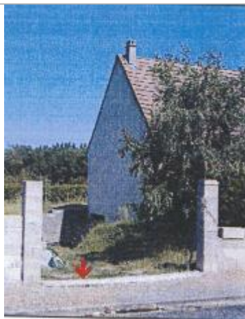
10 Le Prés Denis (photo CETE Normandie Centre)
