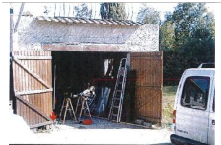
13 Rue de Trouville (photo CETE Normandie Centre)
