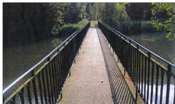
2 Rue de l'isle (photo CETE Normandie Centre)
