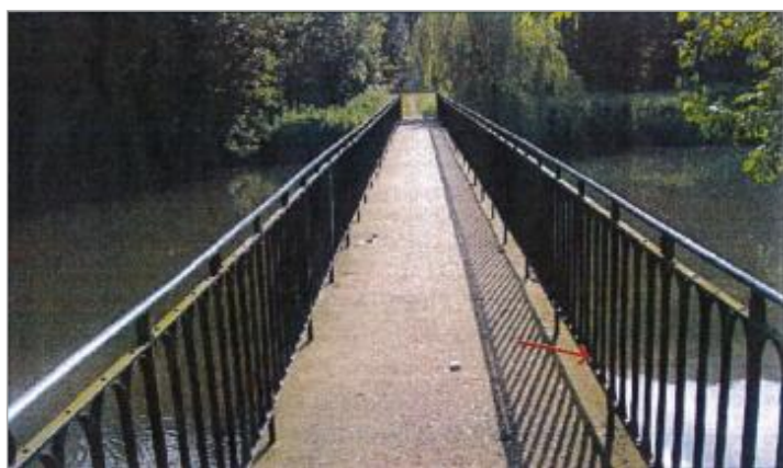
2 Rue de l'isle (photo CETE Normandie Centre)
