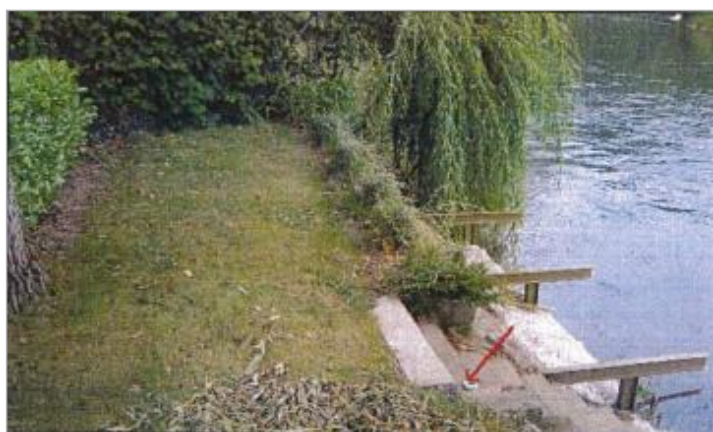
3 Rue de Louvedalle (photo CETE Normandie Centre)
