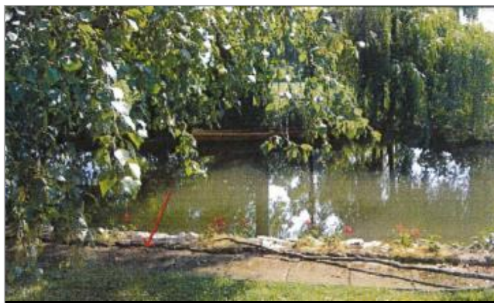
Chemin du Mouché (photo CETE Normandie Centre)
