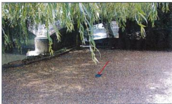
17 Route d'Evreux (photo CETE Normandie Centre)
