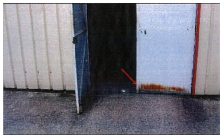
5 Rue des Peupliers (photo CETE Normandie Centre)
