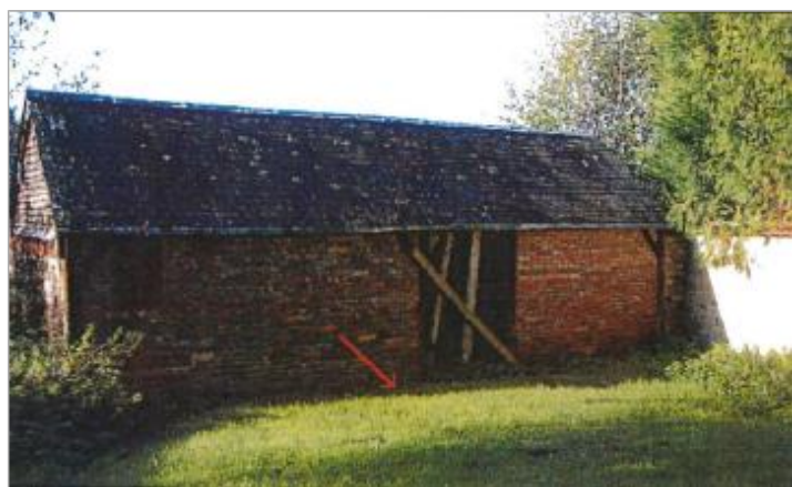
Lavoir rue des Marais (photo CETE Normandie Centre)
