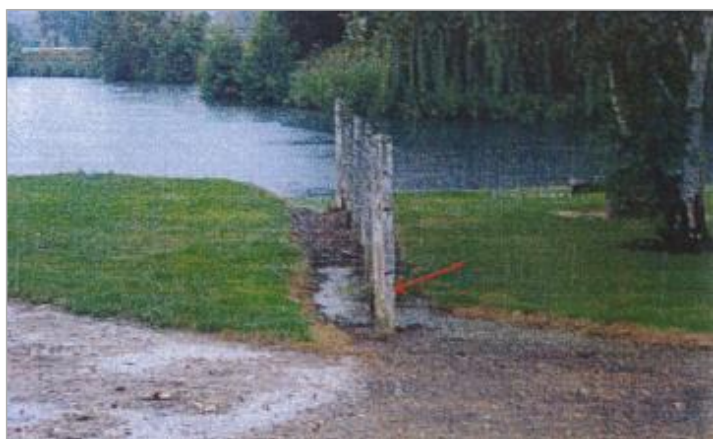
7 Rue des Marais (photo CETE Normandie Centre)
